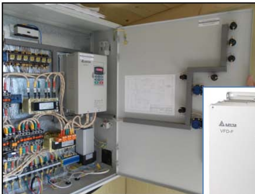
Шкаф управления насосами с ПЧ
