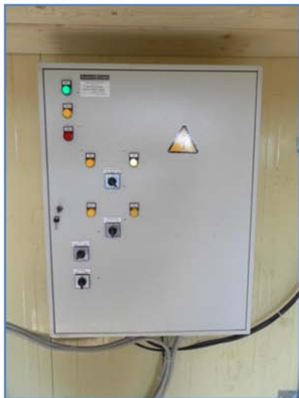
Шкаф управления насосами с ПЧ
