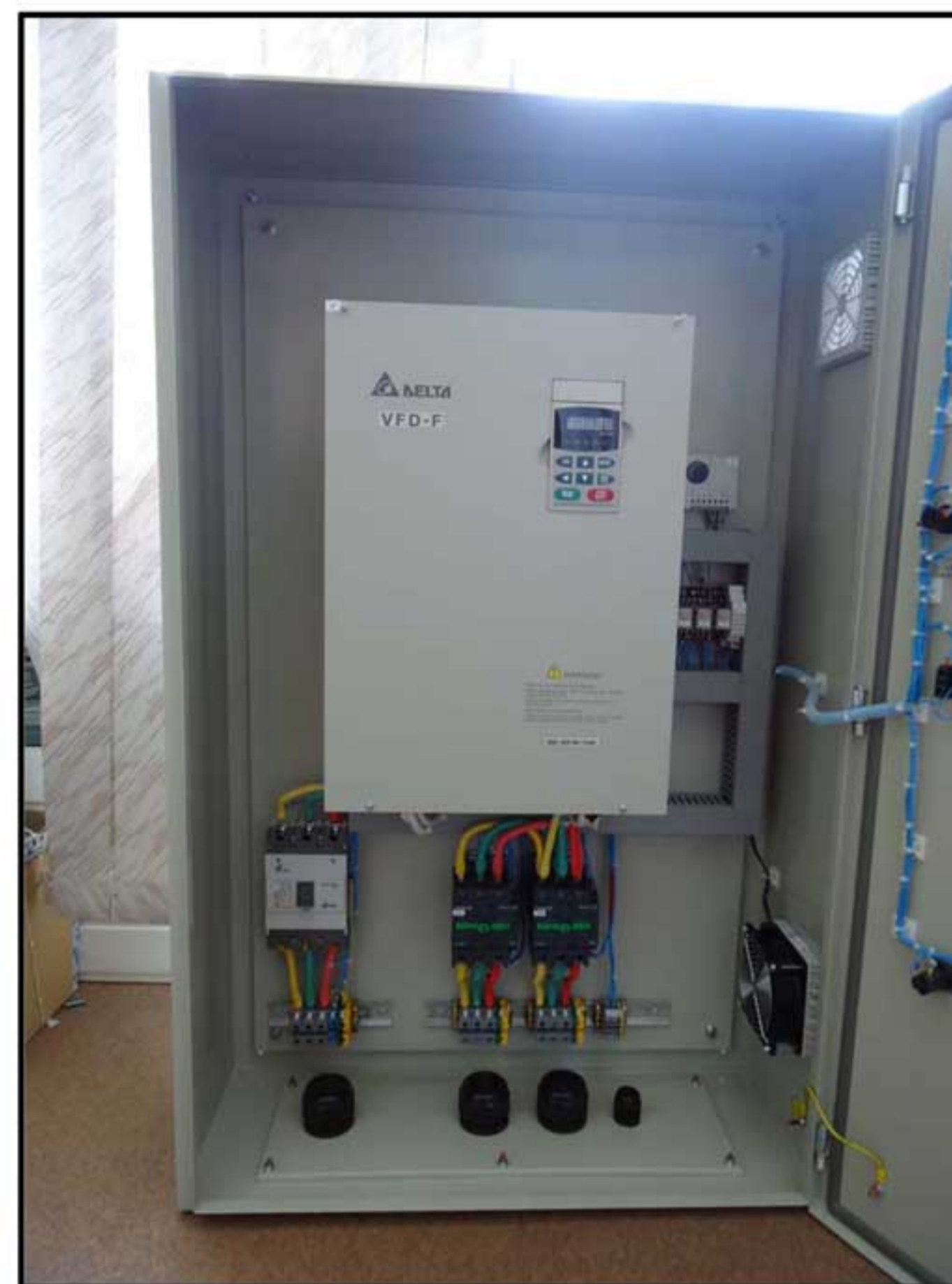
Шкаф управления с преобразователем частоты VFD-F
