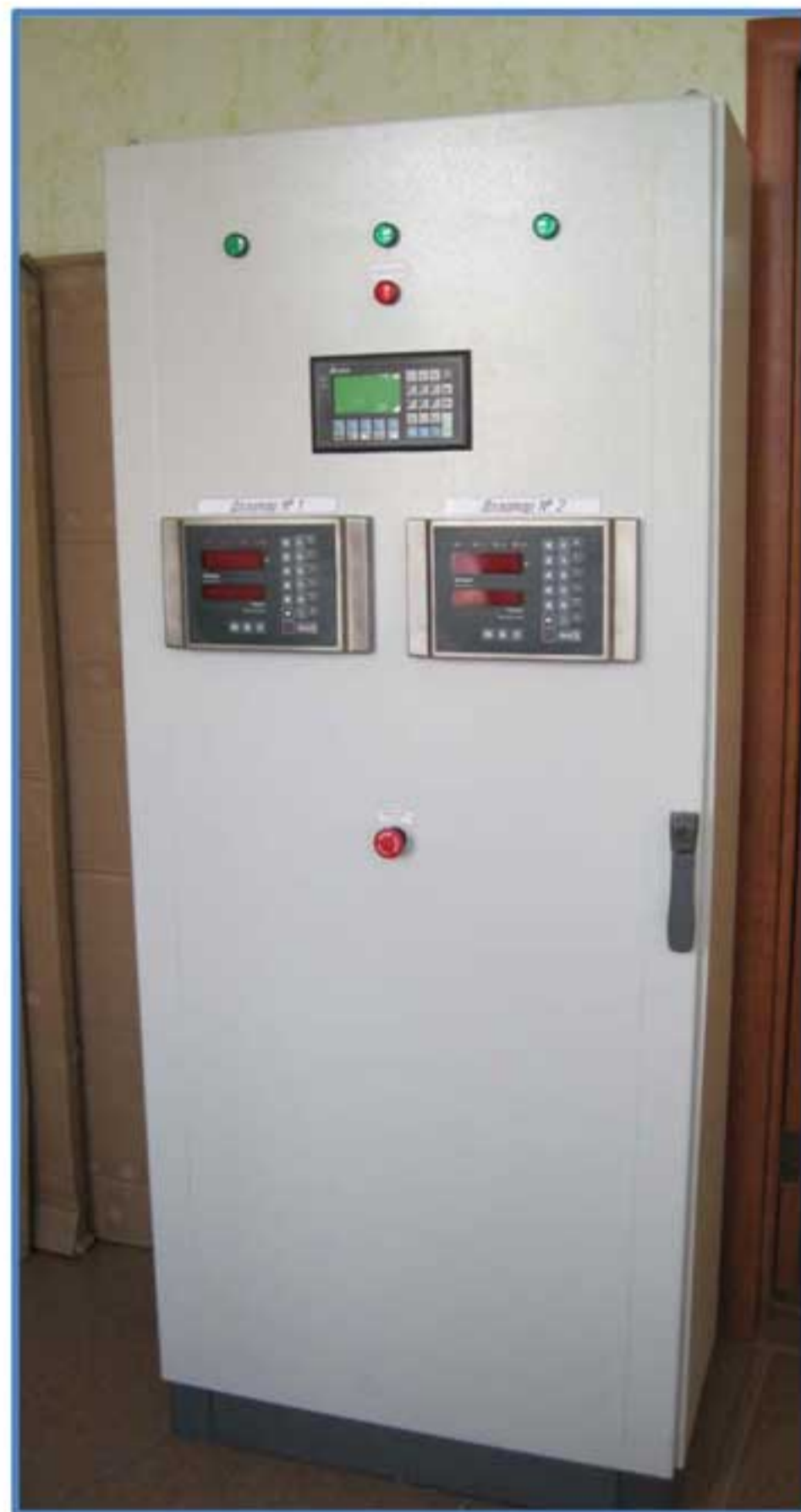
Шкаф управления с панелью TP-04G
