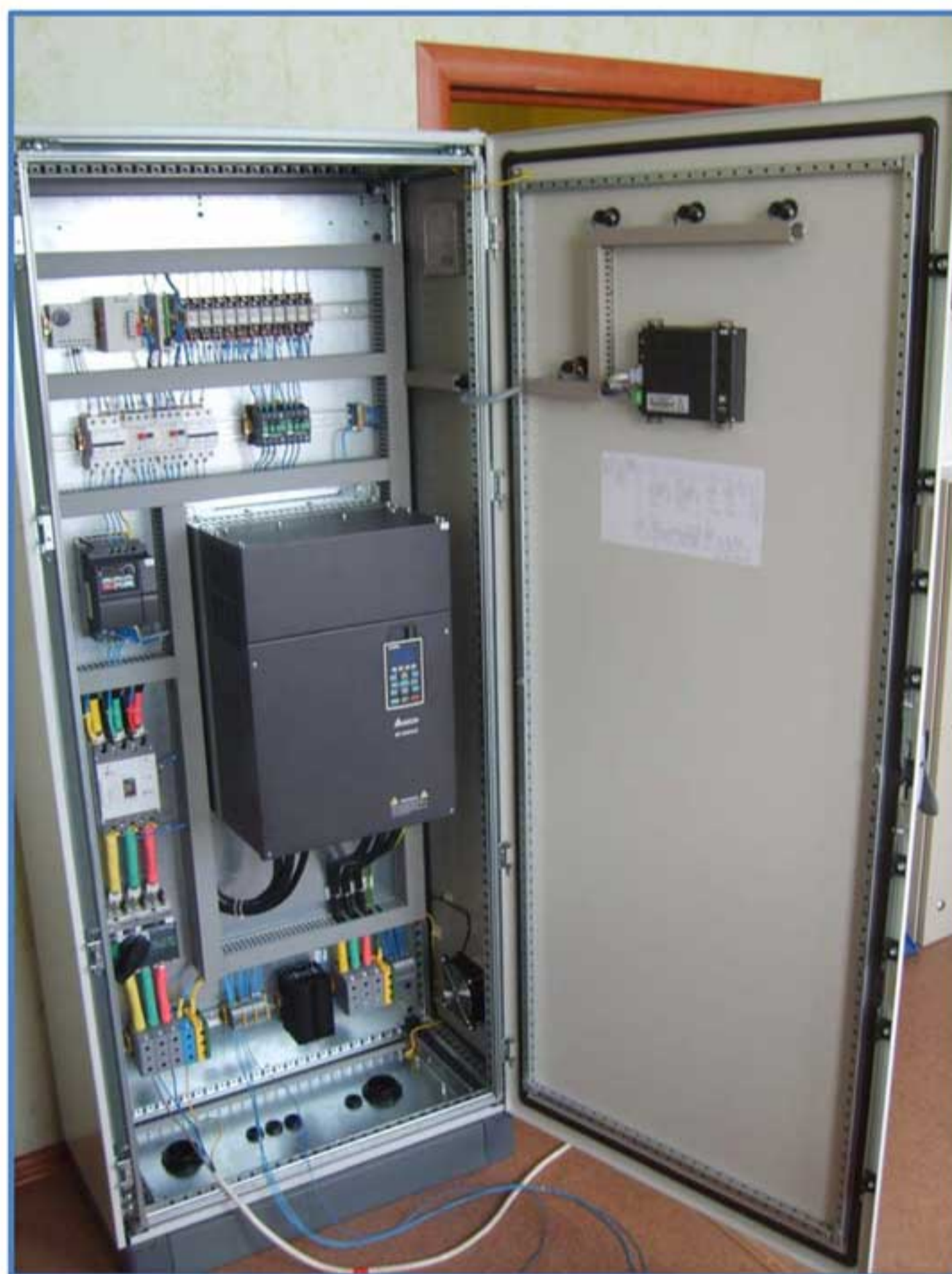
Оборудование Delta внутри шкафа управления
